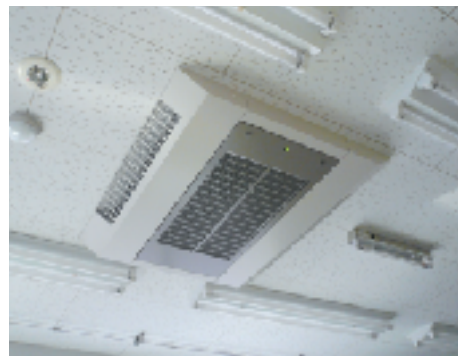
当社が2005年から導入している電気集塵+オゾン+紫外線光触媒滅菌
