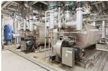
ボイラー及び圧力容器
