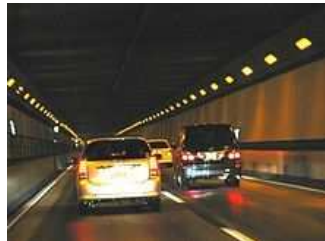
トンネルの天井板
