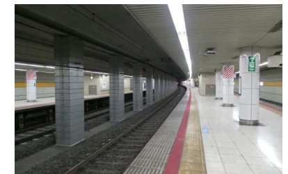
鉄道の駅の地下式構造部分の壁及び天井板
