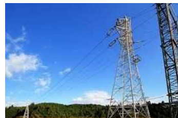
送電設備（ケーブル含む）
