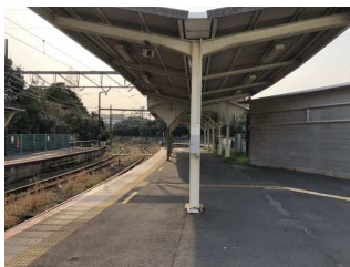
プラットホームの上家
