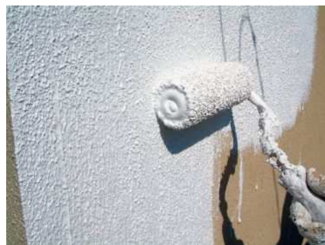
ローラー工法
